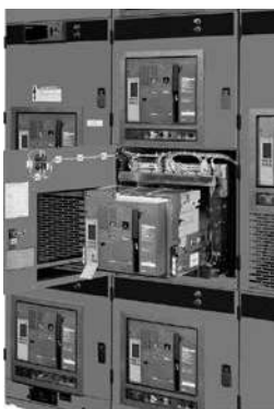
Interruptor NW removido en PZ4
