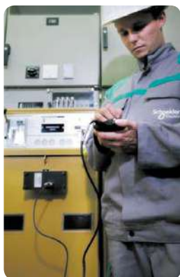
Pruebas de equipos
