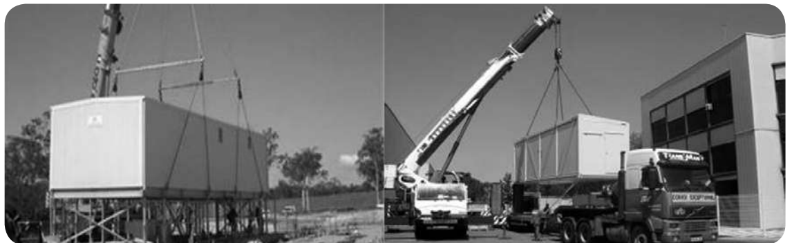
Instalación en sitio
