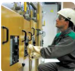
Puesta en Marcha de instalaciones eléctricas
